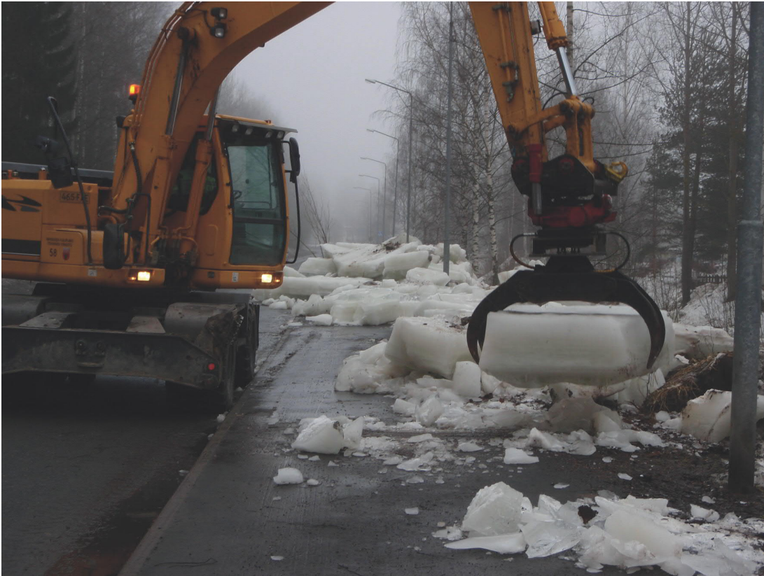
Kuva 7. Jään poistoa Vantaanjoesta ennen kevättulvaa. (kuva: Riihimäen kaupunki 2011)
