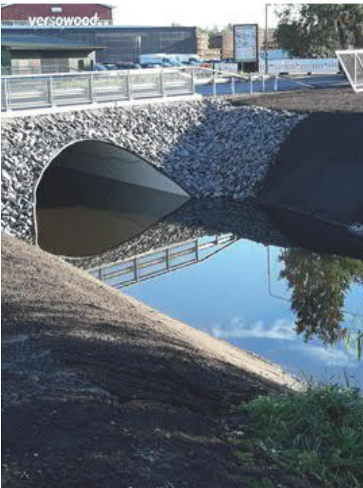
Kuva 8. Teollisuuskadun uusi siltarumpu. (Hämeen ELY-keskus 2020)
